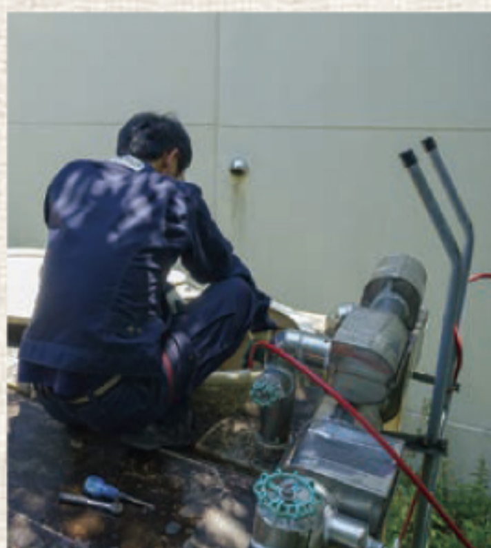
貯水槽の清掃中
